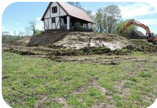
Radovi na infrastrukturi – protupoplavni platoi – Hrvatske vode
