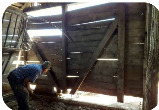
Štala – betoniranje, popravak strunulih podsjeka BED
